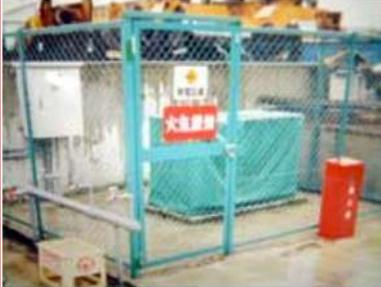
深さ100メートル前後の深井戸は、普段は飲料水として使われておりますが、災害時でも使えるように非常用発電機を置いてポンプを作動させるよう施したものです。蛇口や消火栓を設けておりますので飲料用・消火活動用として使用できます。
